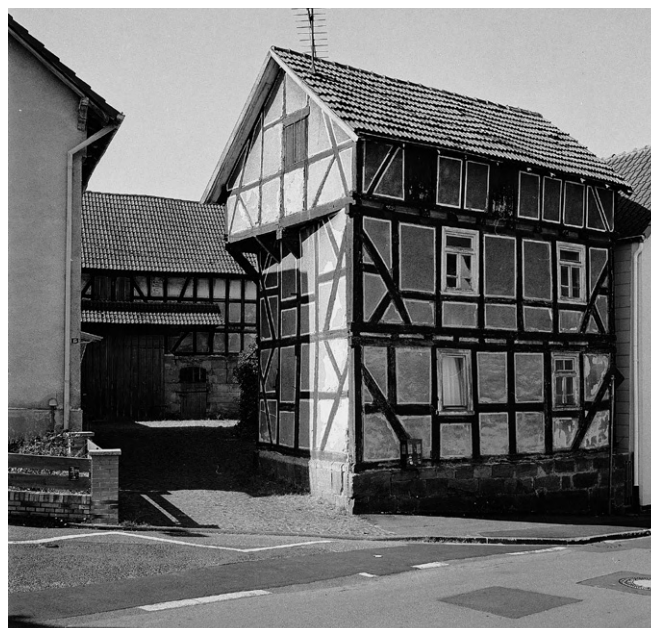
Moischer Straße 15, Gesindehaus
