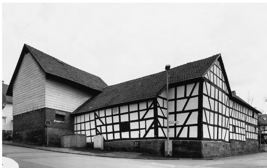
Cappeler Markt 7/Moischer Straße, Wirtschaftsgebäude
