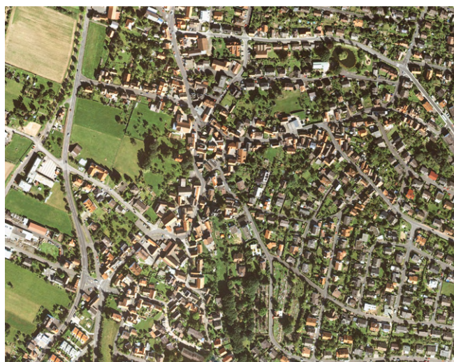
Orthofoto Ortsteil Cappel, M. 1 10.000
