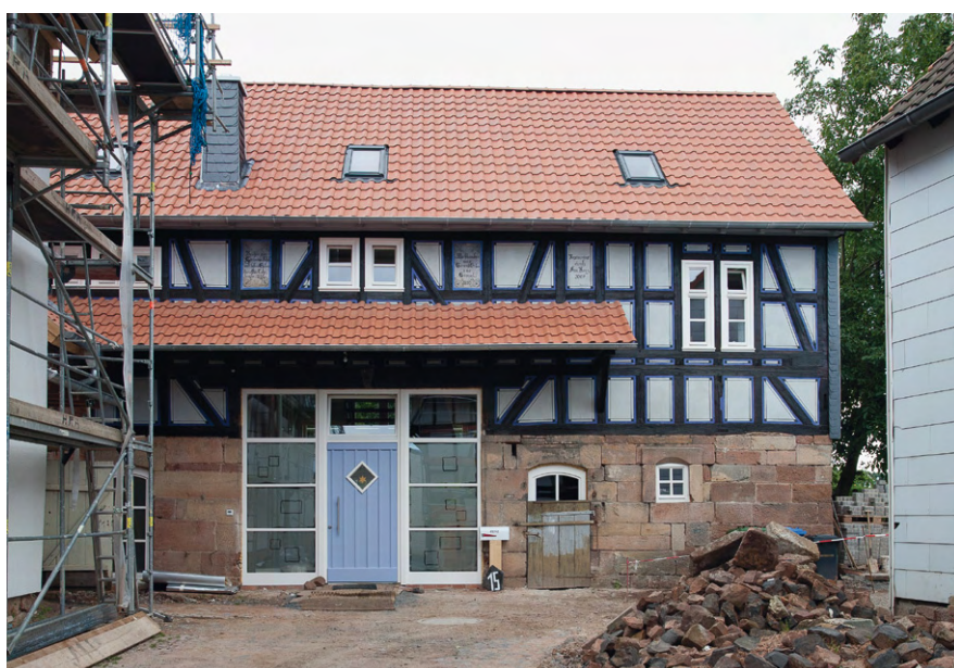
Moischer Straße 15, Scheune
