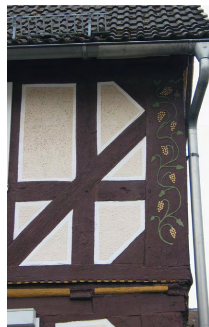
Marburger Straße 3, Detail der Fachwerkzier
